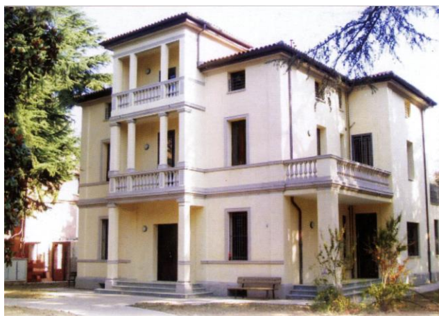
F. Malpensa - S. Lazzaro di Savena
